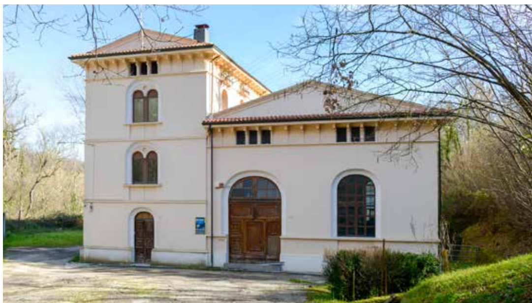
Centrale idroelettrica De Cecco a Fara San Martino in località Viscardi.
