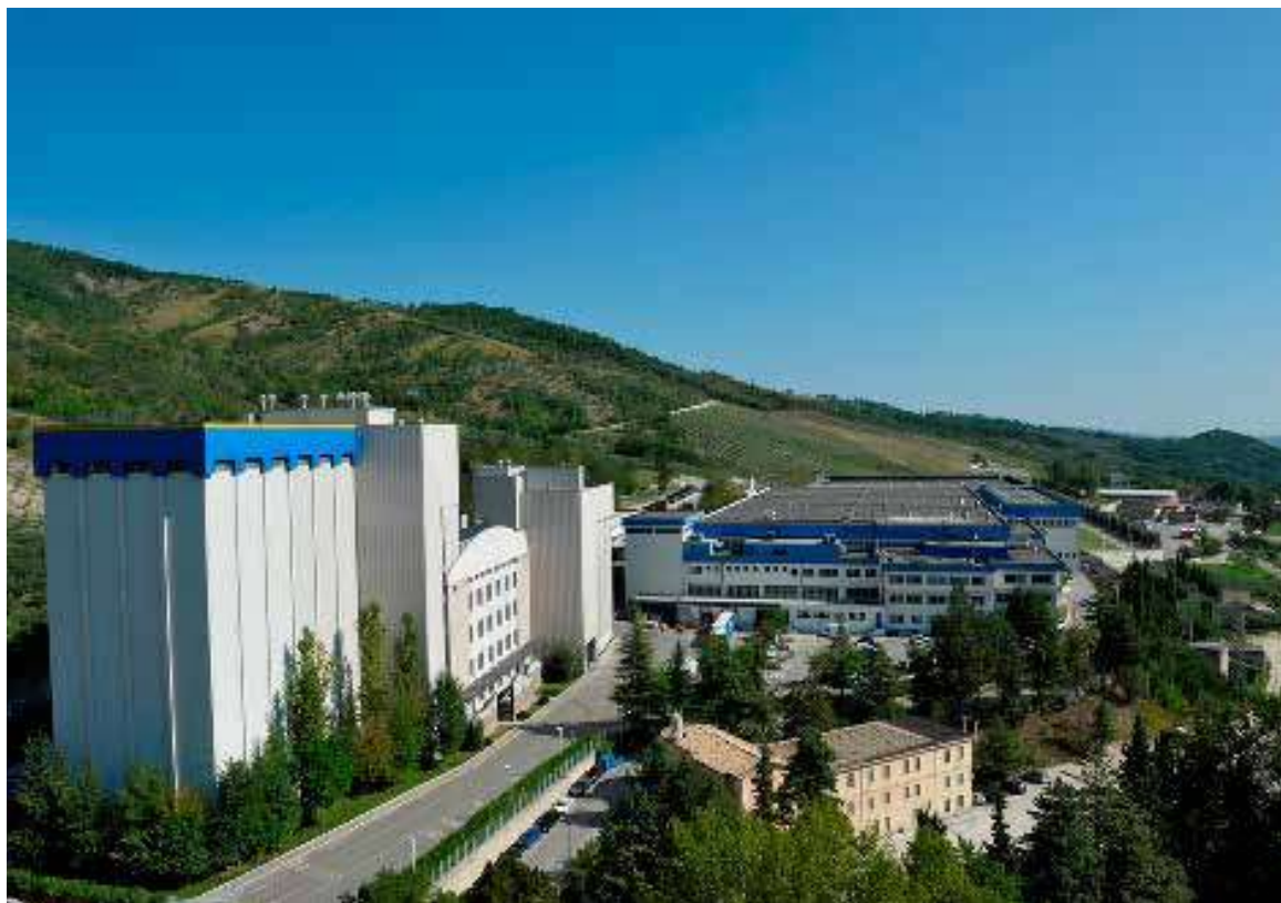
Vista OVEST dell'Unità Produttiva di Fara San Martino con le relative aree verdi interne al perimetro e collinari
