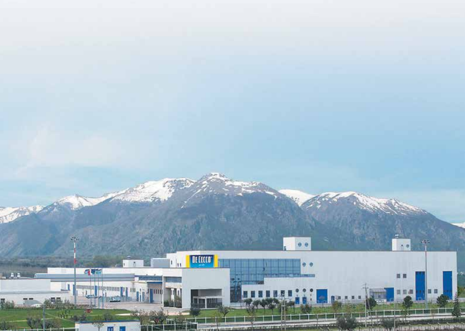
Lo stabilimento di Ortona con lo sfondo della Majella.
